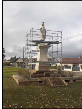
Pendant les travaux
